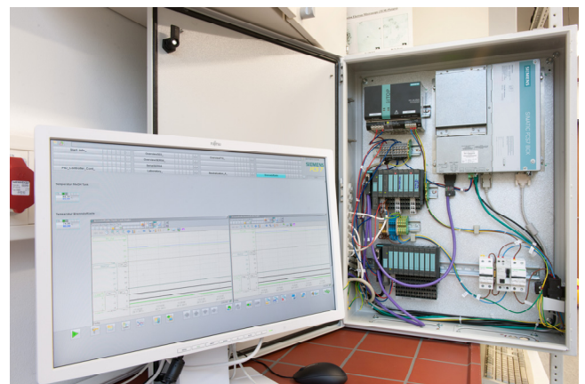
Automatisierte Erfassung der Kenngrößen mit dem neuen Prozessleitsystem
