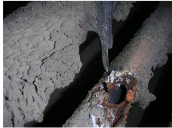
Rohrreißer in einem Überhitzerbündel (Quelle: Warnecke, GKS)
