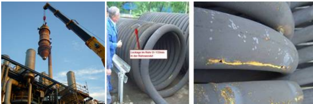
Demontage 40to Wärmetauscher; Leckage in unbeschichteten Anlagen
