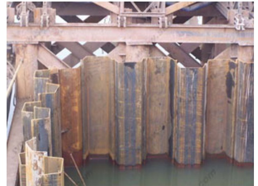
Spundwand mit Biofilmkorrosion
