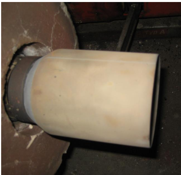
Bild 137: Eingebautes, beschichtetes Flammrohr in Testanlage nach 640 Starts und 282 h Betriebszeit. Es ist noch keinerlei Schädigung sichtbar.
