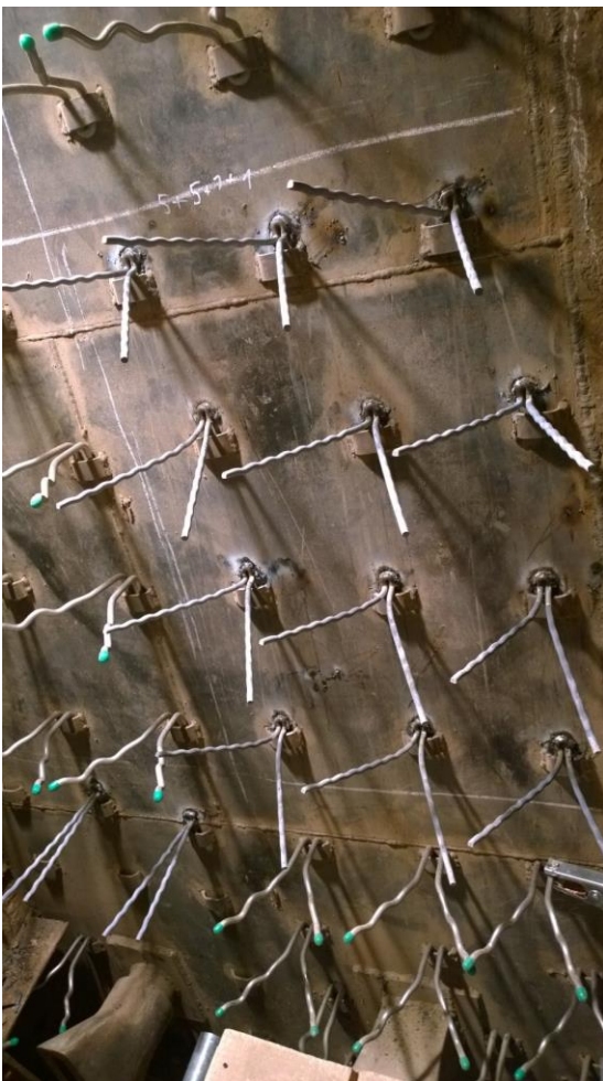
Bild 138: Eingebaute Anker in der Einlaufkammer eines Zementwerks
