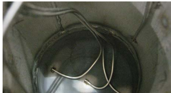
Abbildung 5: Innenansicht der Brennkammer im Reformerreaktor
