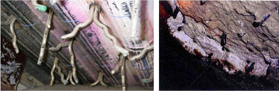
Bild 2.1: Eingebaute Anker für Feuerfestauskleidung in einer Müllverbrennungsanlage (links,[3]) und Alkalibursting mit korrodierten Ankern (rechts,[4])
