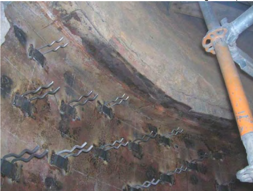
Bild 6.5: Eingebaute Versuchsanker im Zementwerk Wittekind
