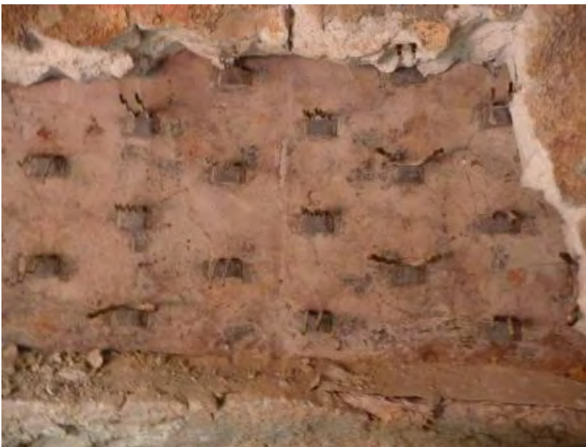
Bild 7.60: Ausbruch der Anker im Zementwerk Wittekind
