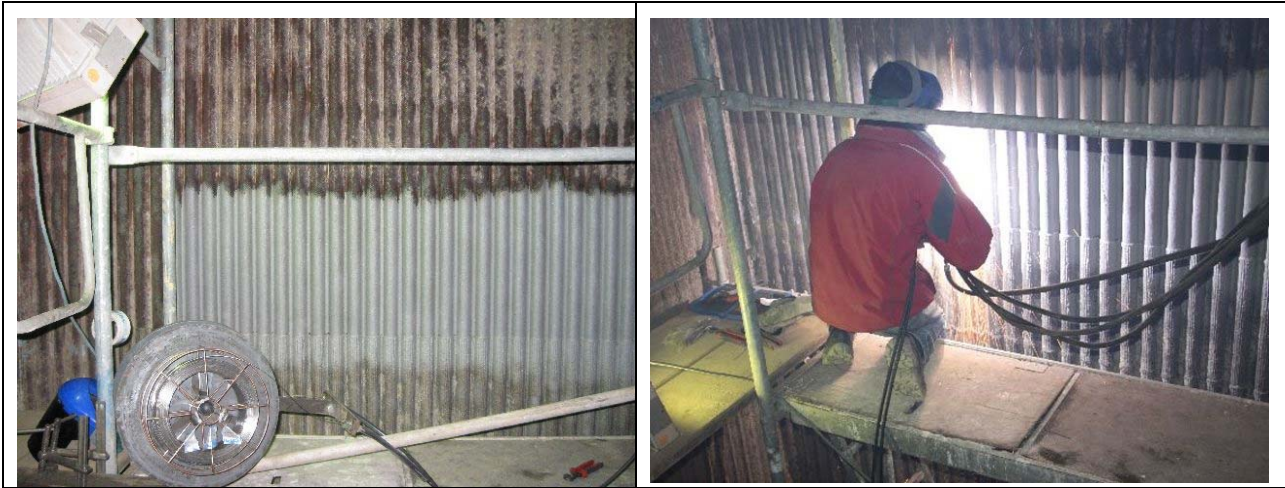
Bild 41: Dimensionen im Brennerschacht mit Flossenwand und der Bereich der Beschichtung
