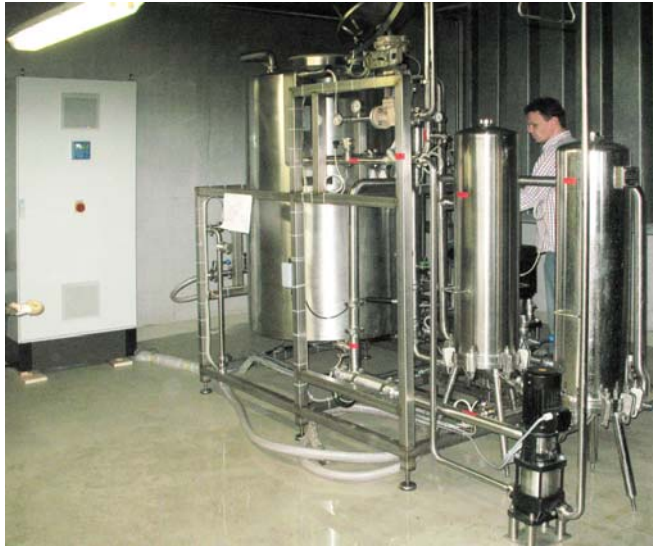
Abb.1: Desinfektionsanlage mit BDD-Elektroden in einem Kühlturm bei Schrobenhausen (Esau & Hueber GmbH)
